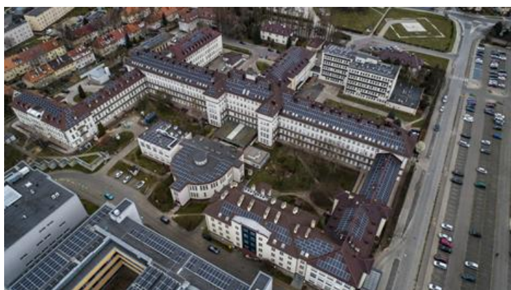
Farma fotowoltaiczna zlokalizowana na dachach i elewacjach budynków Szpitala Klinicznego w Szczecinie 9
