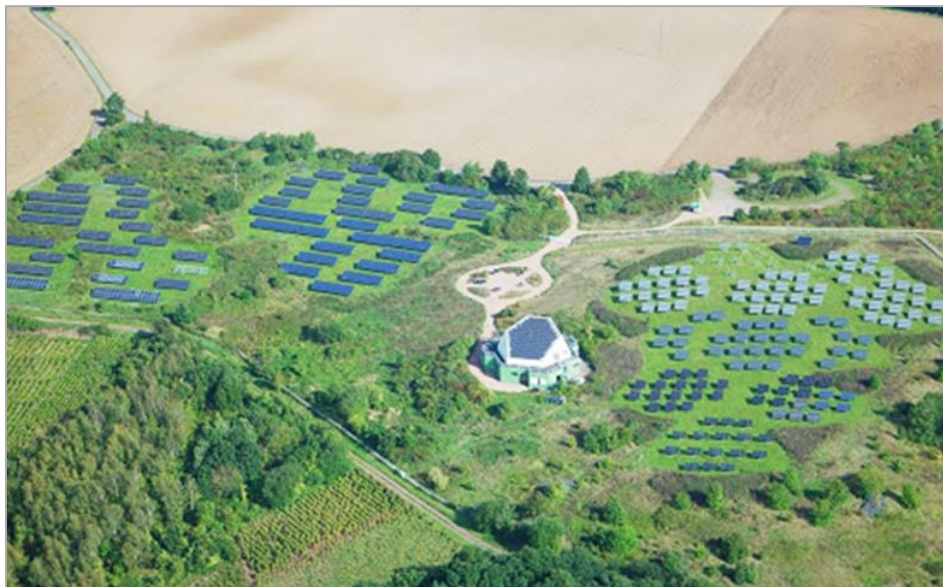
Ryc. 14 Przy dobrym projekcie parku solarnego, czego przykładem jest obiekt Gondorf Kobern w Niemczech, stworzono nie tylko miejsce atrakcyjne dla ptaków, ale obecnie chroni się go na prawach rezerwatu dla zagrożonych gatunków roślin i zwierząt (Źródło: https://www.cire.pl/pliki/2/Tryjanowski_wplyw_sloneczn.pdf )
