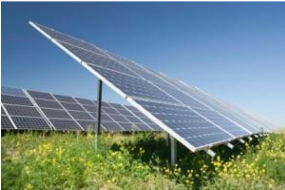
Fot. 4 Sposób montażu paneli fotowoltaicznych na stelażach wbijanych bezpośrednio do gruntu.
