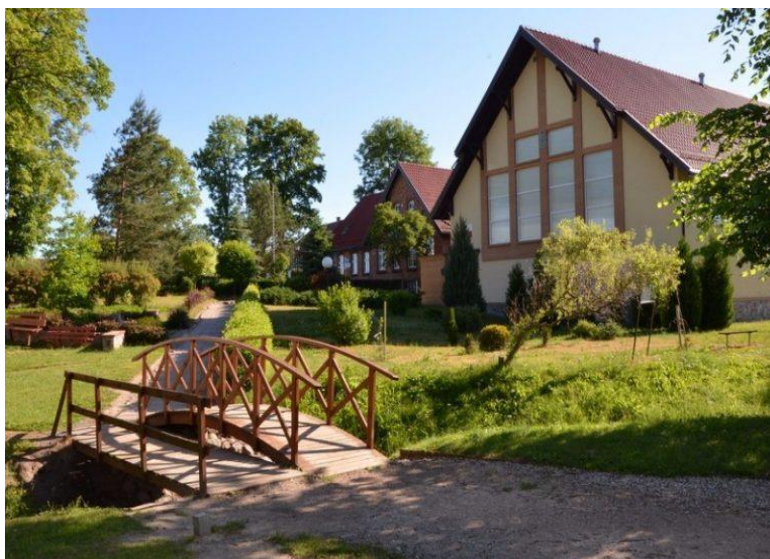
Zdjęcie nr 11 – Szkoła Podstawowa im. Marszałka Józefa Piłsudskiego w Gąskach – budynek szkoły (widok od strony ogrodu)
