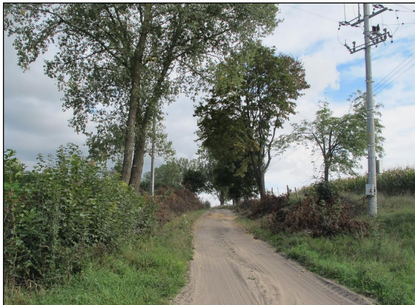
Fot. 17. Fragment badanego odcinka istniejącej drogi przecinającej oba warianty planowanej obwodnicy - droga polna Gąski - Zatyki (M.Grabowski, 2018).
