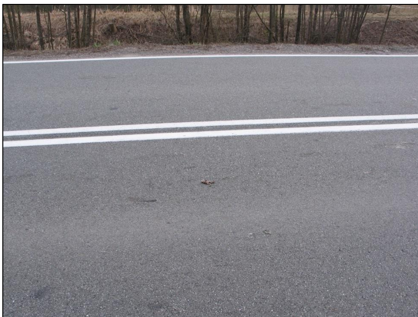
Fot. 35. Martwe płazy na fragmencie istniejącej drogi krajowej nr 65 przy wjeździe do miejscowości Gąski od strony południowej (K.Lubelska-Gawryszewska, 2018).
